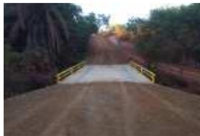
Esta obra beneficiará todos os produtores, facilitando o escoamento da produção e também a passagem de máquinas agrícolas com mais tranquilidade. Feita com vigas metálicas e concreto armado.
